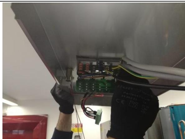
6. Die Steckverbinder von der Verkabelungsplatine entfernen und das Bauelement auswechseln.
