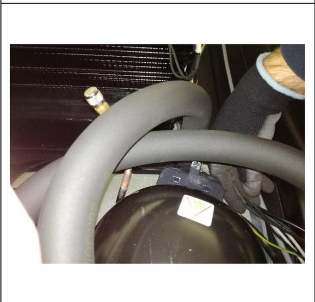
10. Die Schellen befestigen und die Drähte erneut an den entsprechenden Klemmen anschließen.
