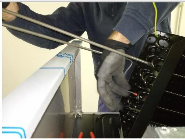
**12.** Die Kabel wieder mit den Verschlussmuttern befestigen.
