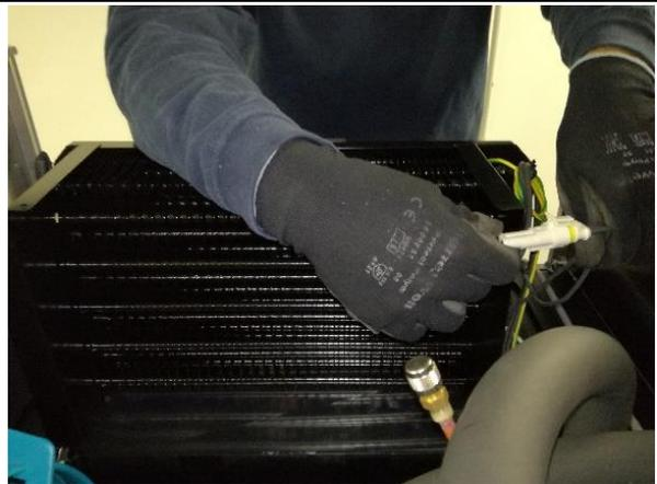
**7.** Die Heizungskabel mithilfe eines Flachkopfschraubendrehers vom Steckverbinder abziehen.
