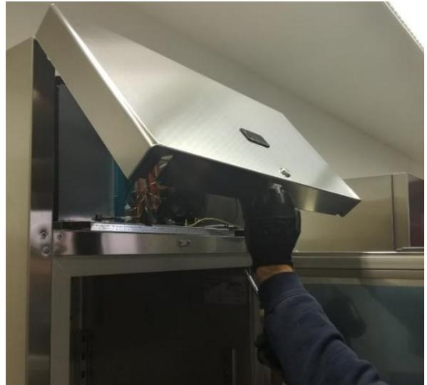
3. Den Hauptschlüssel verwenden, um den Block von seinem Sitz zu entfernen und das neue Schloss zu installieren.
