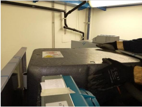
**18.** Den Sicherheitsriemen an der Isolierungshaube schließen.
