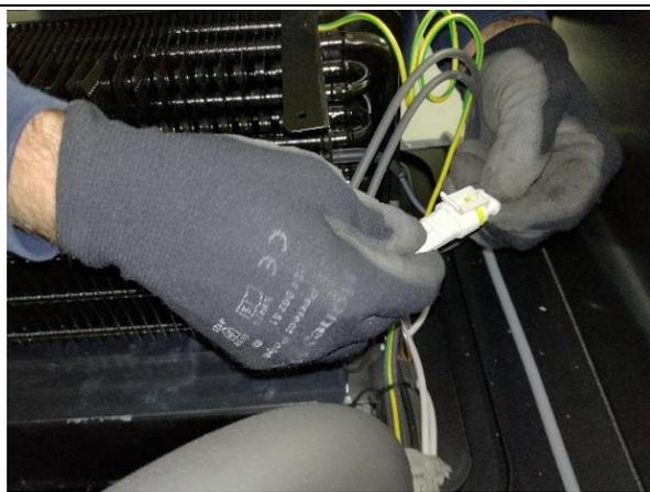
**11.** Die Heizung austauschen, dazu die Kabel in die entsprechenden Bohrungen an der Seite des Verdampfers einführen.
