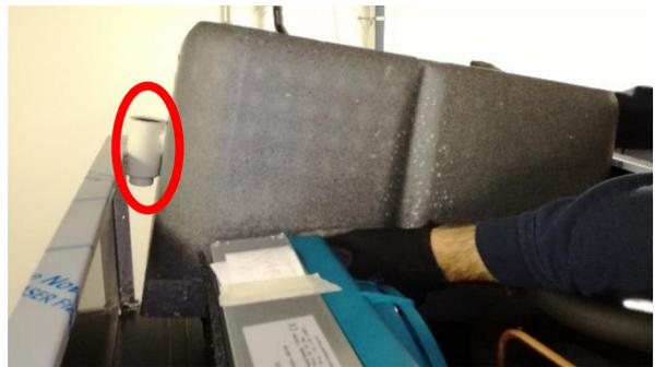
5. Die Befestigungsschrauben des Verdampfers lösen.
