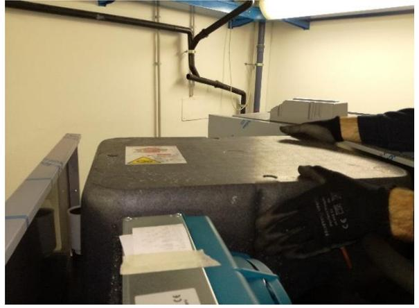
**15.** Den Sicherheitsriemen an der Isolierungshaube schließen.
