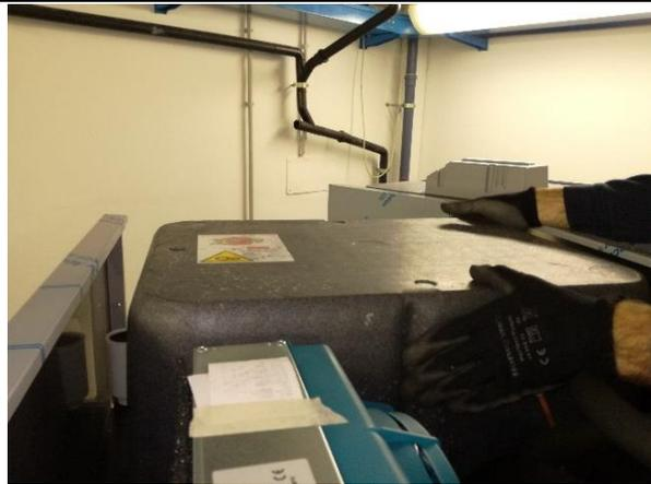
**16.** Den Sicherheitsriemen an der Isolierungshaube schließen.
