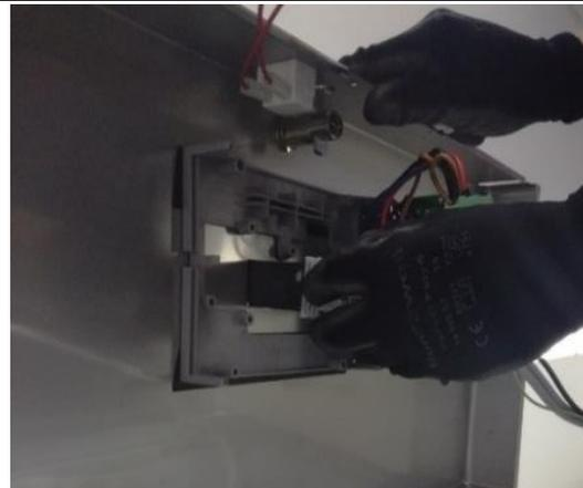
6. Den Thermostat von innen nach außen abziehen und das Bauelement auswechseln.
