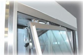
Heben Sie zuerst die rechte, äußere Scheibe an und ziehen diese unten gefühlvoll zu sich heraus. Verfahren Sie bei der zweiten Scheibe genauso.
