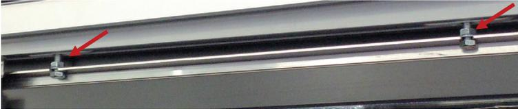
c) anschließend können Sie durch Hinein- oder Hinausdrehen der Einstellschrauben die Höhe der Schiebetüre justieren.
