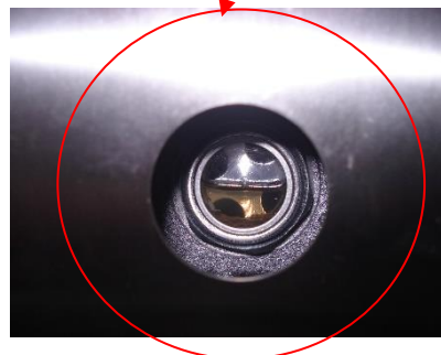
Abbildung 1. Ölstand-Schauglas
