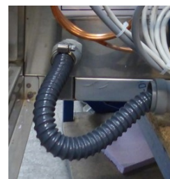
Abbildung 6: Geruchsverschluss
