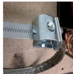
Abbildung 7: Heizband vorbereiten
