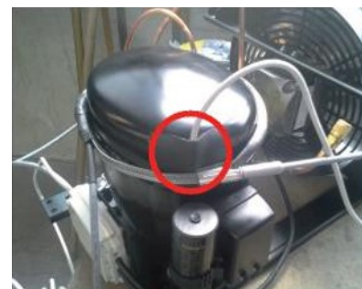
Abbildung 9: FühlerX606 montieren
