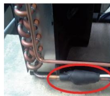
Abbildung 10: Fühler X607 montieren
