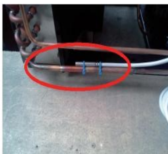
Abbildung 10: Fühler X607 montieren
